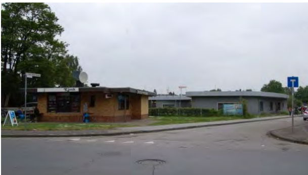
Abbildung 28 Kiosk und neue Kita am Indestadion (links)
