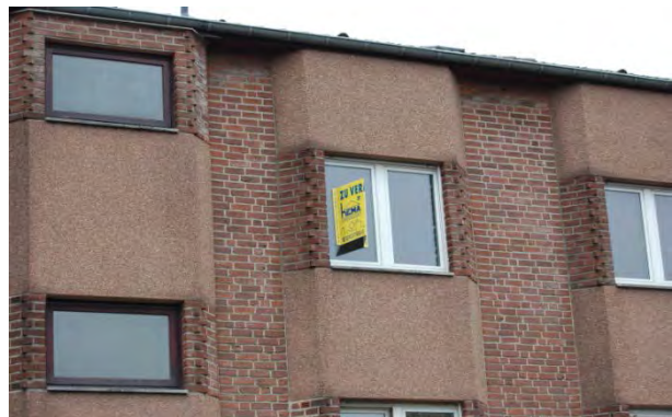
Abbildung 42 Wohnungsangebot an der August-Thyssen-Straße (rechts)
