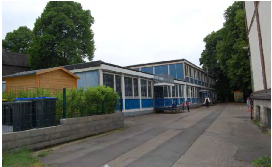
Abbildung 108 Containerpavillon mit Kita und VHS
