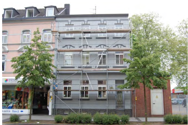
Abbildung 136 Sanierungsmaßnahme Langwahn (rechts)
