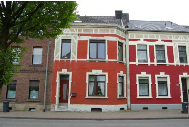
Abbildung 133 Fassadenbeispiel Odilienstraße (links)
