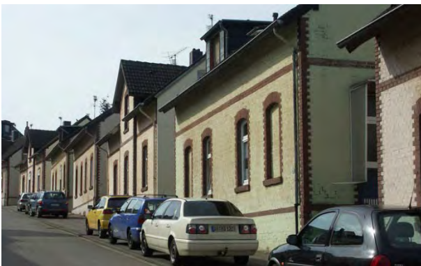
Abbildung 41 Siedlungshäuser in der Hüttenstraße (links)
