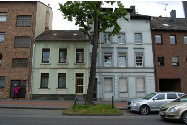
Abbildung 131 Fassadenbeispiele Röthgener Straße (links)
